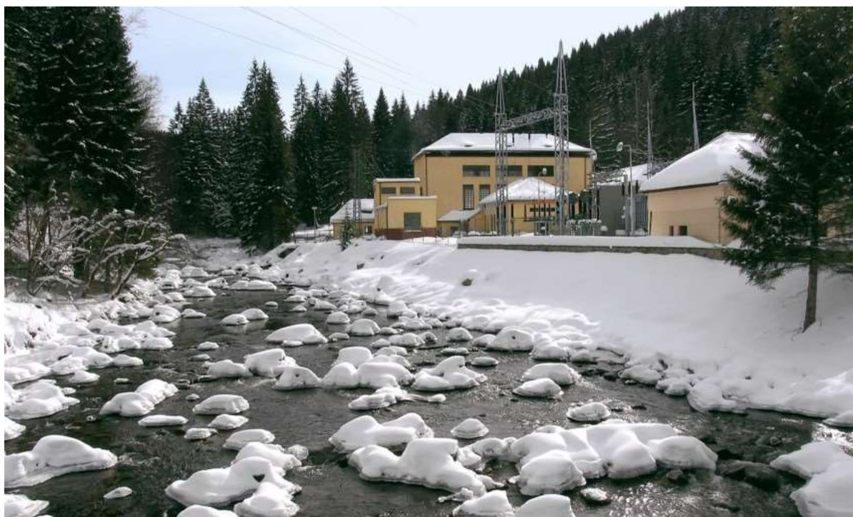
Obr. Vodní elektrárna Vydra
